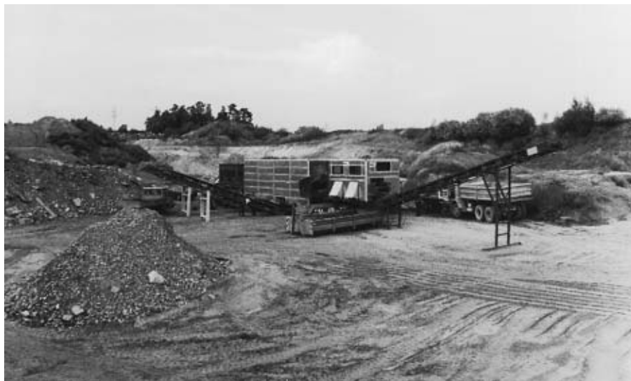
Foto 4: Aufbereitung mineralischer Bauabfälle in einer mobilen Anlage
