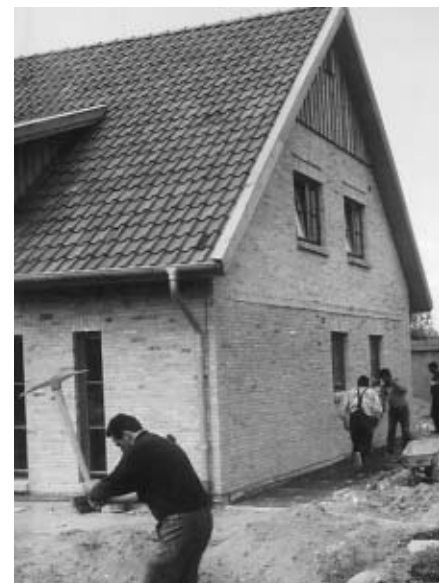
Foto 3: Produktrecycling: Neubau mit alten Ziegeln (Expo-2000-Projekt)
